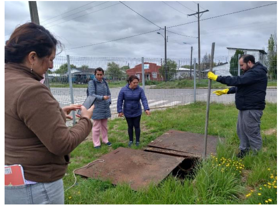
Dren PTAS Población Union y Esfuerzo
