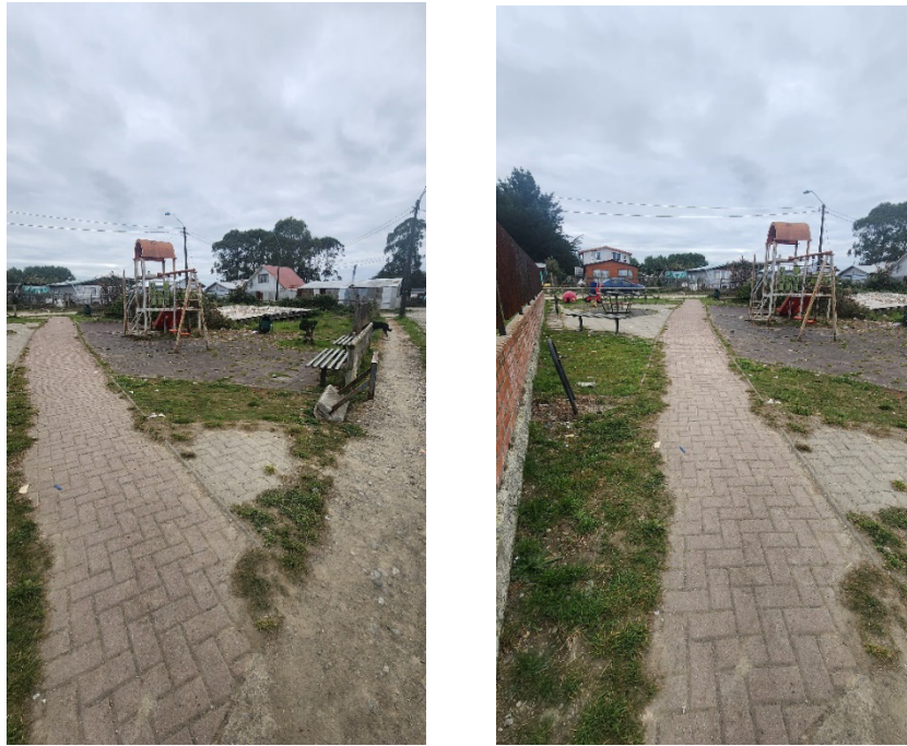
estado actual de la sede y área verde Los Coihues.
