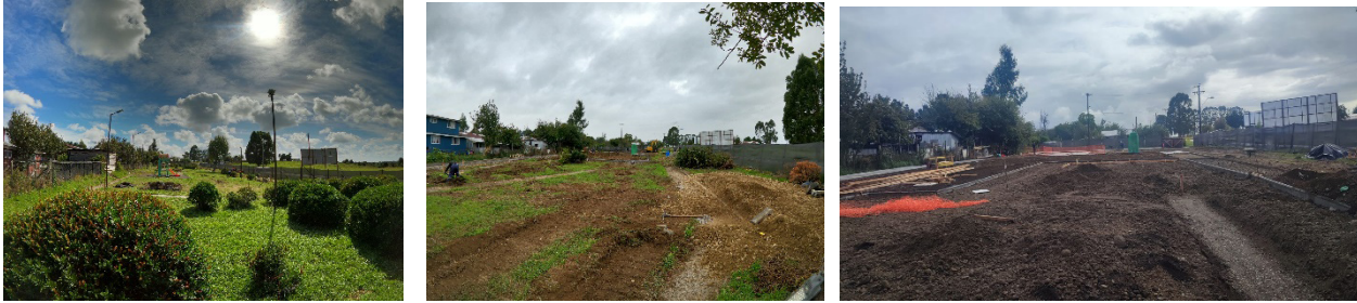
Avance de ejecución de obra.
