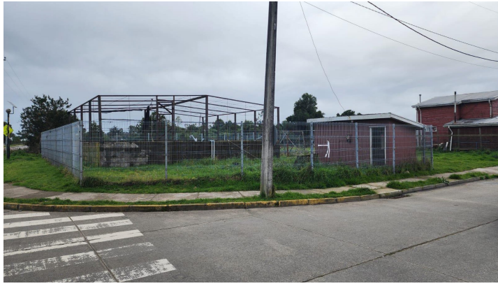
Planta de tratamiento Aguas Servidas (PTAS) Población Union y Esfuerzo
