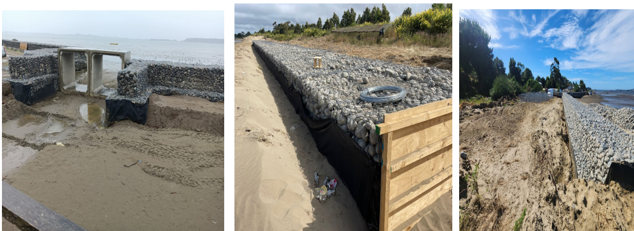
Avance ejecución de obras
