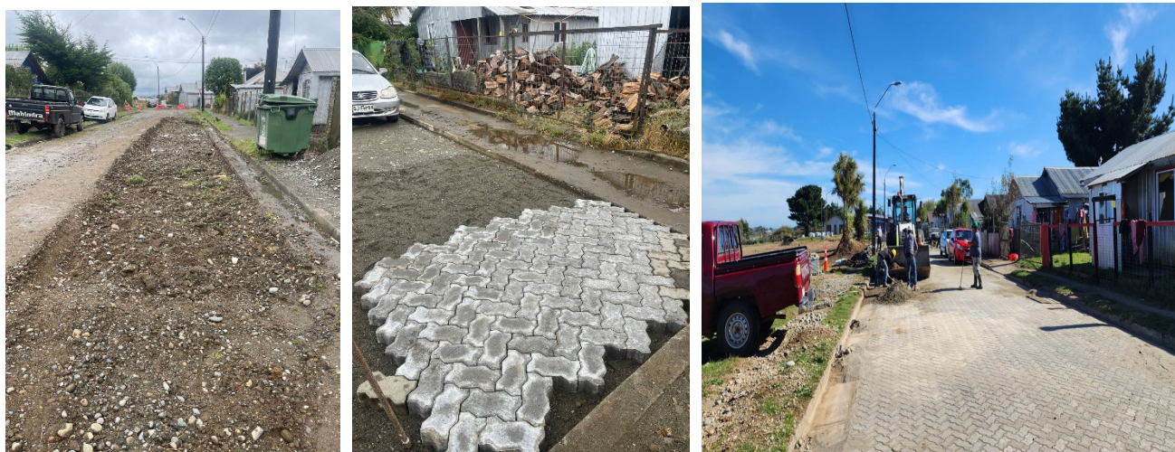
Avance ejecución de obras
